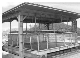
降雨実験施設
